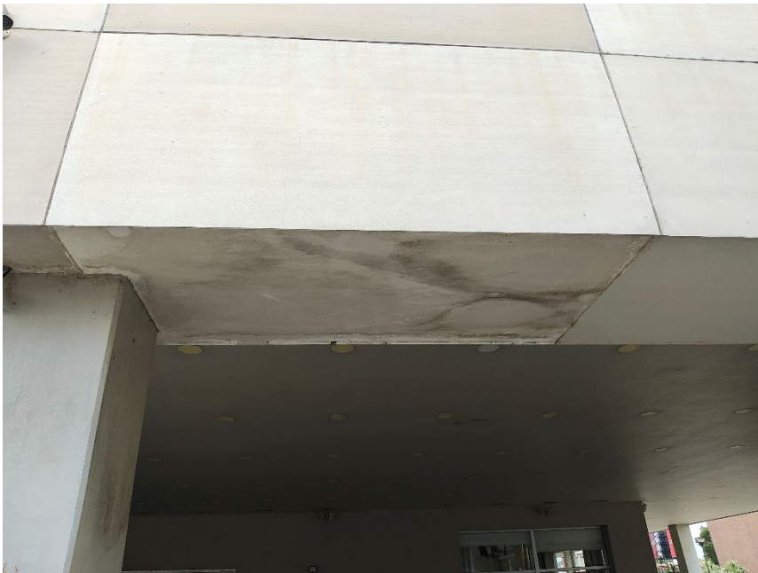
Imagen 6. Placa de superboard a reponer.
