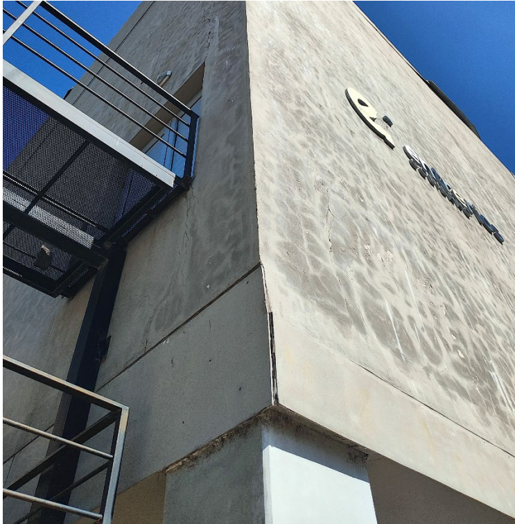
Imagen 7. Reajuste de esquina. Reparación de placas.
