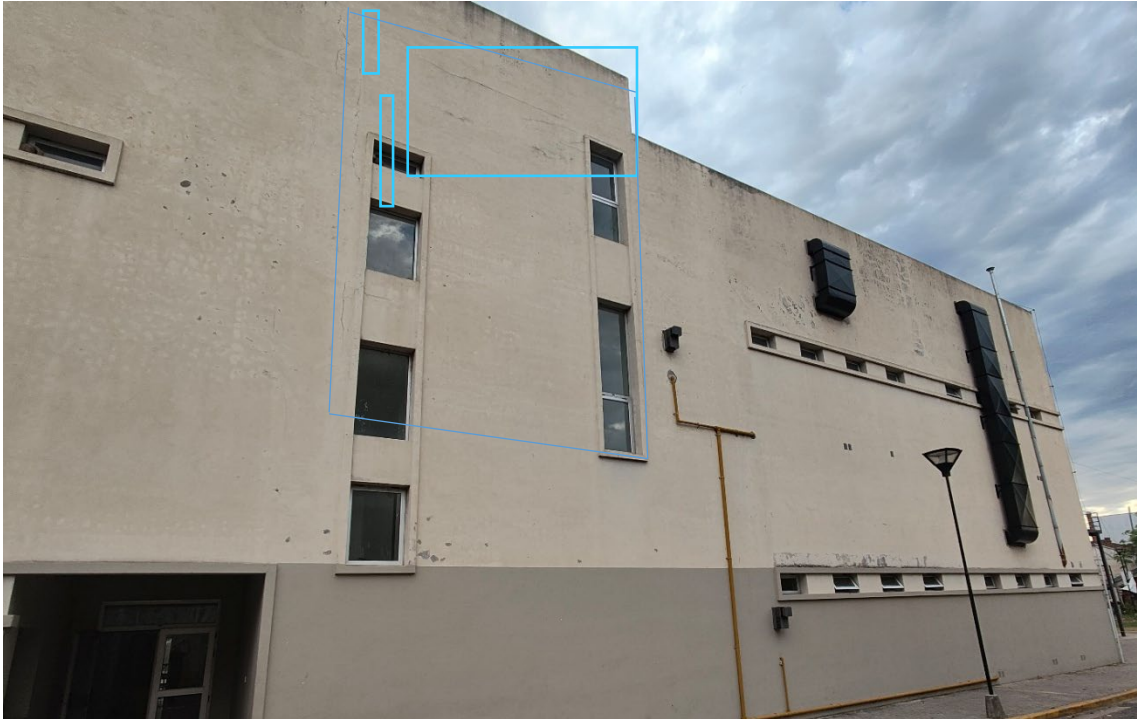
Imagen 3. Núcleo de escalera fisurado y mapeo generalizado.
