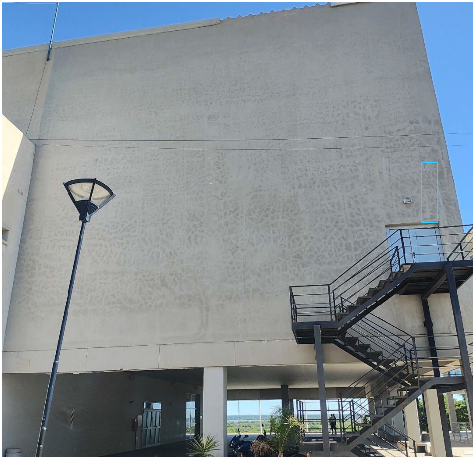
Imagen 5: Fisura vertical sobre dintel y mapeo generalizado
